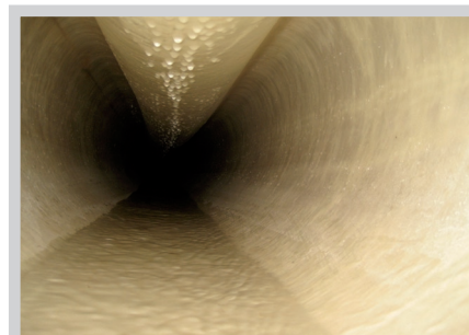
Innenansicht einer sanierten XTRA-Liner Strecke
