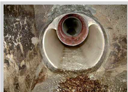
XTRA-Liner nach der Sanierung
